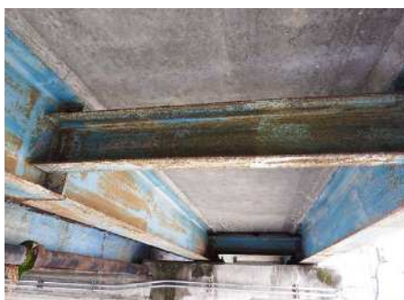
図 1.3 鋼橋の状況例
