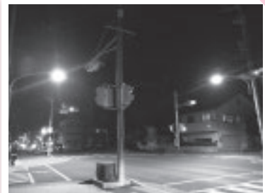
町内街灯等 LED 照明導入事業 町内の道路照明、防犯灯など約 1340 基の屋外照明を LED 化します。
