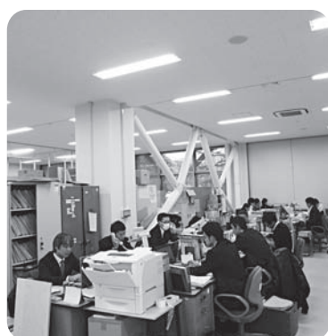
トグル制震工法 (奥に見える筋交い部分)
