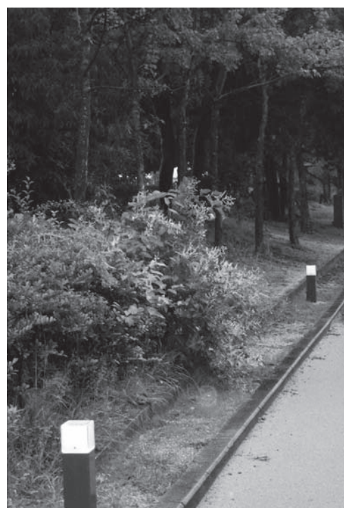
遊歩道で足元を照らす庭園灯
