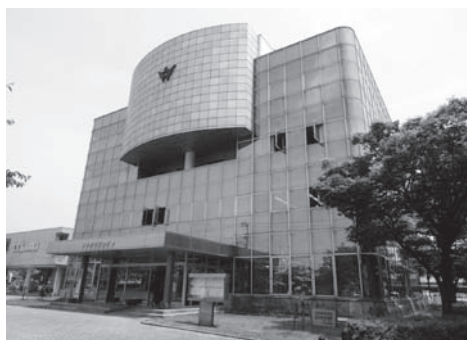
耐震改修予定の本庁舎
