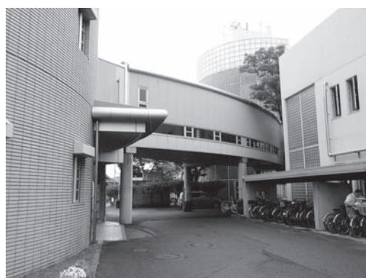
耐震診断が追加になった渡り廊下
