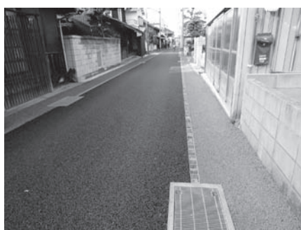
整備が終わった山下地区
