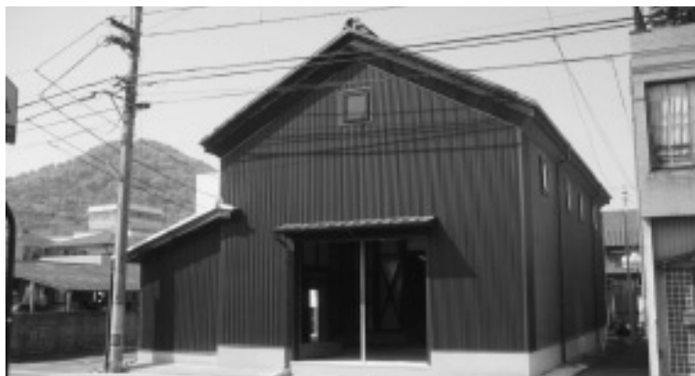
改築中の旧JA倉庫
