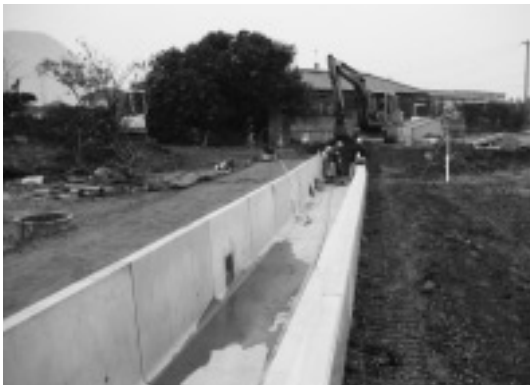
改修工事が進みつつある長縄手幹線水路
