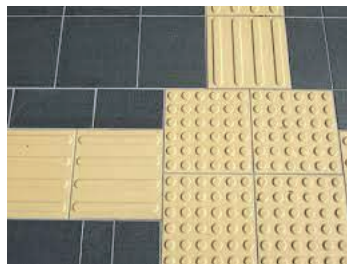
誘導用点字ブロック
