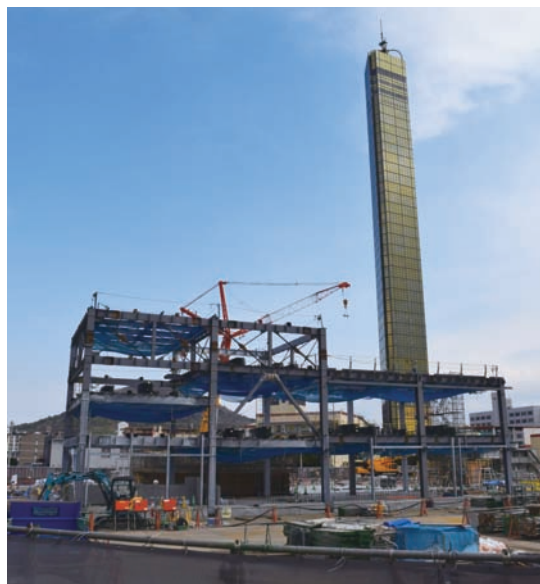
建設が進む水族館
