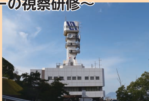
青の山にそびえ立つ海上交通センター
