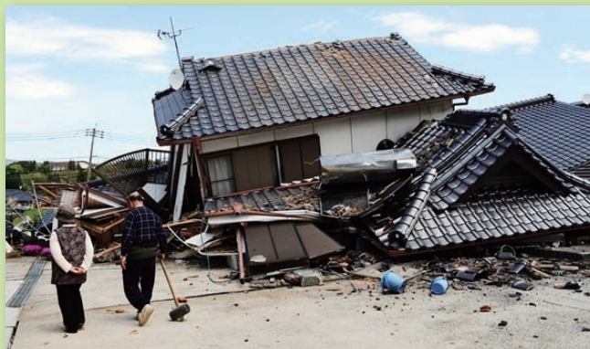
熊本地震での家屋の倒壊
