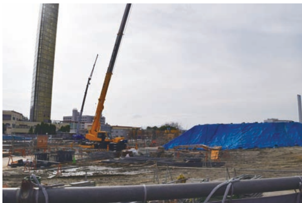
建設中の四国水族館
