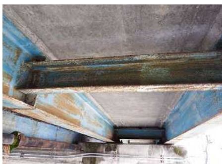
図 1.3 鋼橋の状況例
