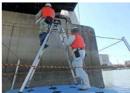
図 3.1 定期点検の様子
