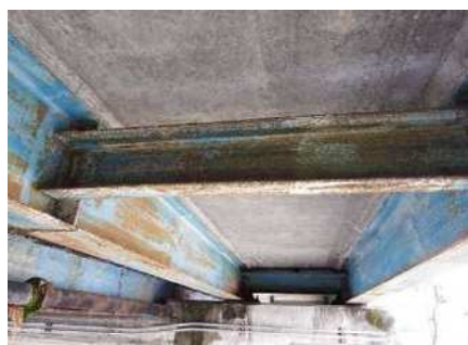
図 1.3 鋼橋の状況例
