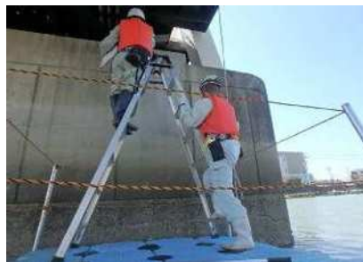
図 3.1 定期点検の様子
