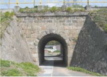
⑦ 旧讃岐鉄道岩屋架道橋
