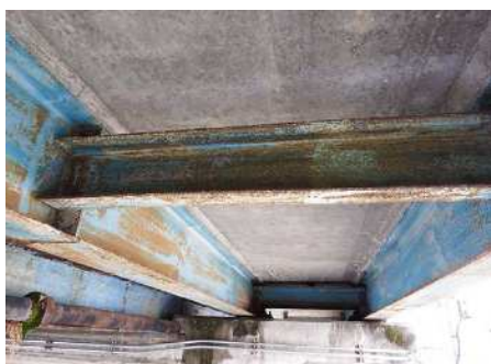
図 1.3 鋼橋の状況例
