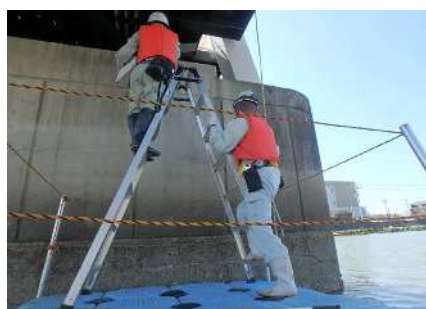
図 3.1 定期点検の様子
