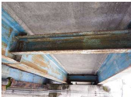
図 1.3 鋼橋の状況例
