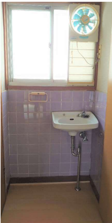
⑧ トイレ横手洗い場
