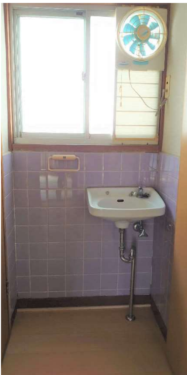
⑧ トイレ横手洗い場
